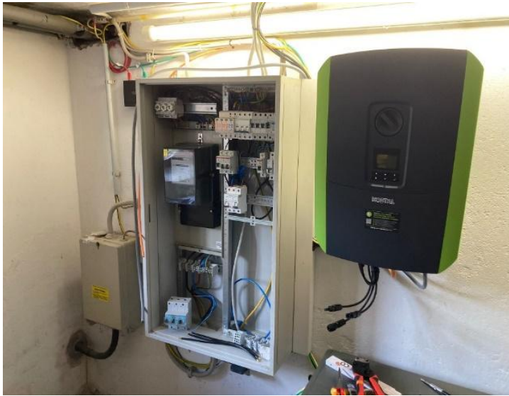
Abbildung: montierter Wechselrichter und Speicher
